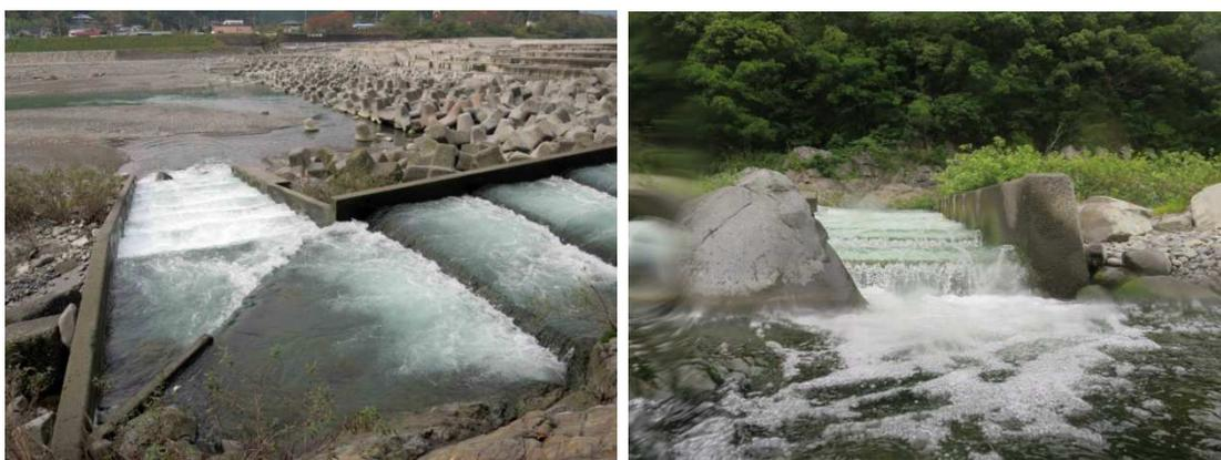
図 1-15 左岸側の階段式魚道。屈曲部を境に流れ方が変化する(左)。上り口には段差ができています
