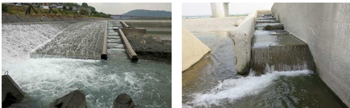
図1-12 四ヶ郷堰右岸側魚道(左)。階段式の魚道の上り口は大きな段差がある(右)
