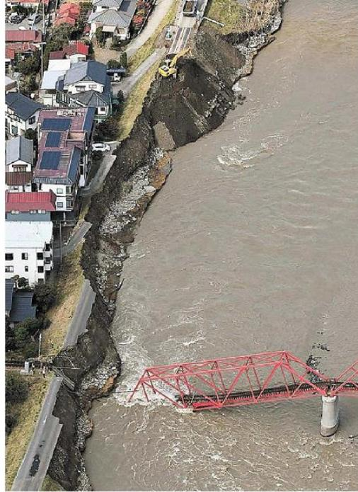
千曲川の増水でえぐり取られた道路。下は崩落した上田電鉄別所線の橋
