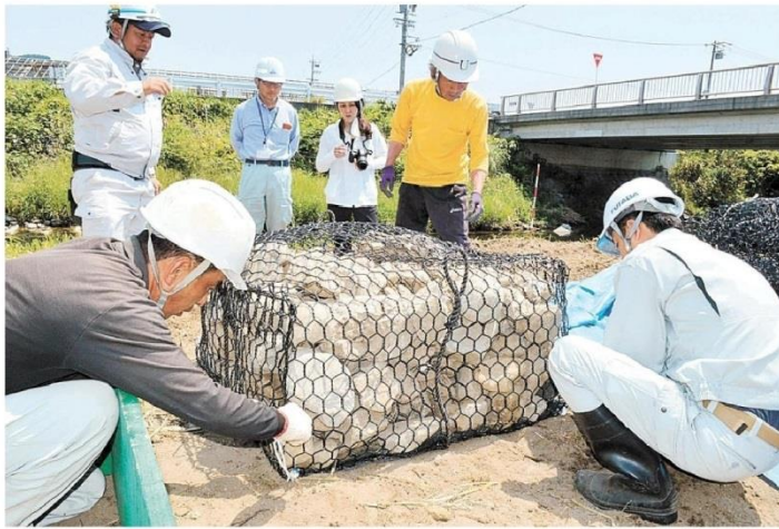
ウナギのすみかとして河川に設置する石倉かご ＝18日午前、静岡市清水区の庵原川
