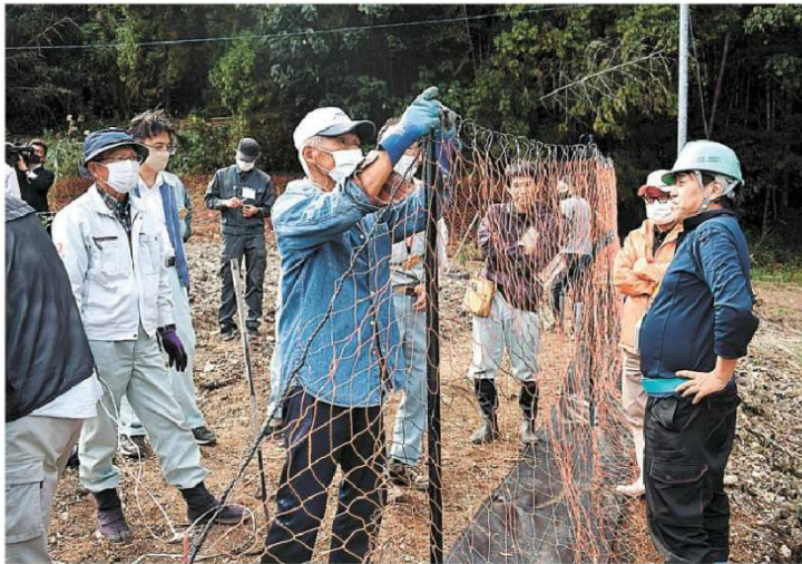
ネット型電気柵の設置に取り組む参加者＝島田市湯日
