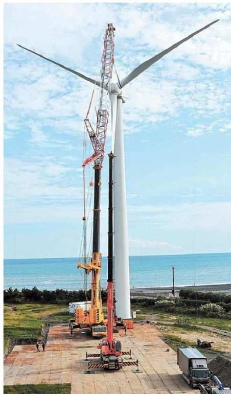
撤去作業が始まった風力発電施設「風電君」 ＝静岡市駿河区
