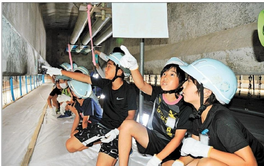
橋の下の工事現場に入る児童ら＝浜松市西区(画像の一部を加工しています)
