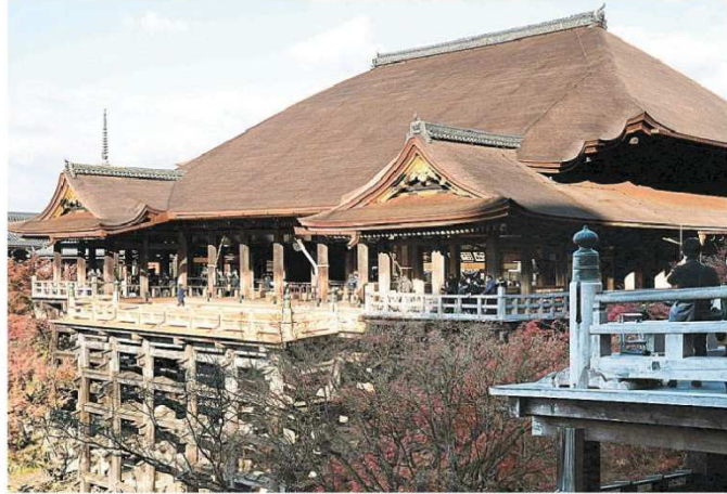
本堂の檜皮屋根のふき替えと床板の張り替え工事が完了した清水寺の本堂。3日午前、京都市
