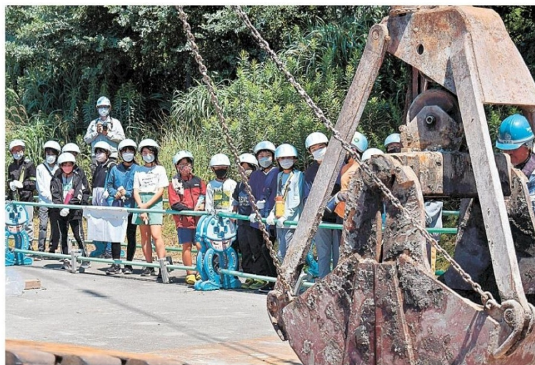
工事現場を見学する村櫛小の児童たち —浜松市西区
