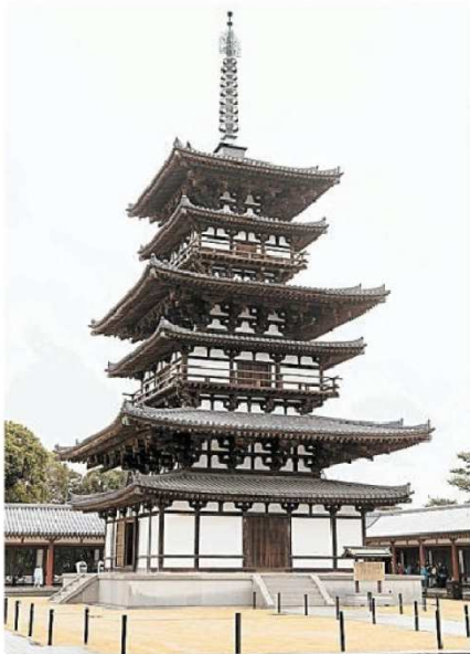
解体修理を終えた薬師寺の「東塔」
